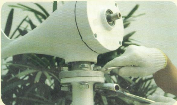
5. Atornille la brida a la punta de torre firmemente con los 4 tornillos, utilice todas las arandelas y tuercas provistas.
