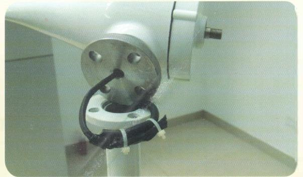
4. Conecte 3 cables a los cables de salida del aere lo suficientemente largos como para poder sacarlos en la parte inferior de la torre.
